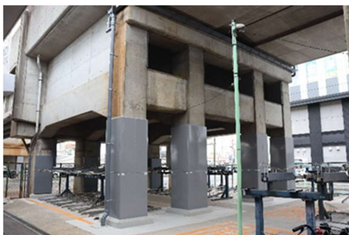
高架橋の耐震補強
