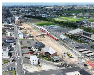
若林駅付近高架化工事
