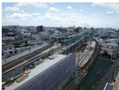
喜多山駅付近高架化工事
