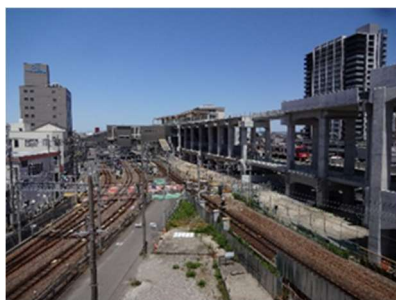
知立駅付近高架化工事
