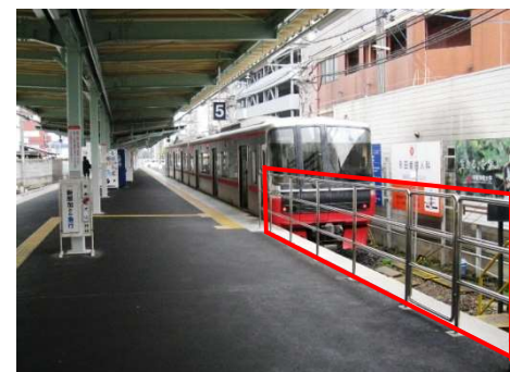
線路終端部の固定柵
