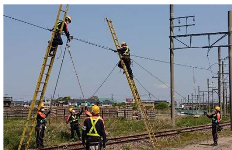
架線断線復旧訓練
