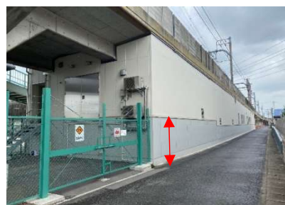
機器設置床面の嵩上
