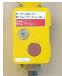
非常通報ボタン
