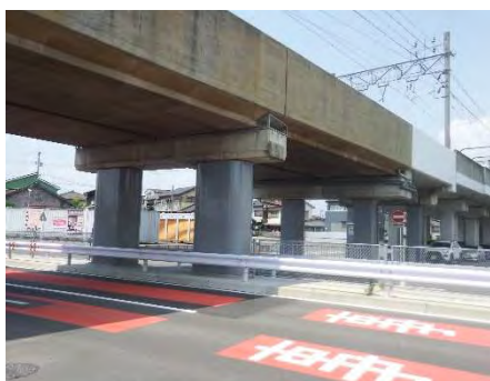
高架橋の耐震補強
