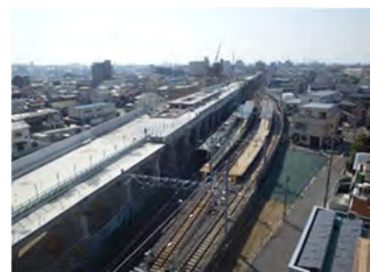
喜多山駅付近高架化工事
