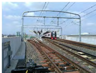
布袋駅付近高架化工事
