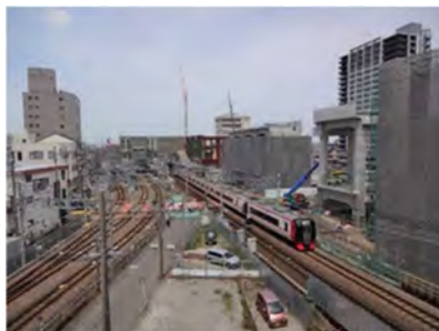
知立駅付近高架化工事
