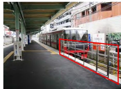
線路終端部の固定柵
