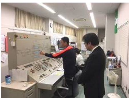
安全統括管理者による現場巡視
