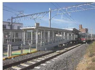
喜多山駅付近高架化工事
