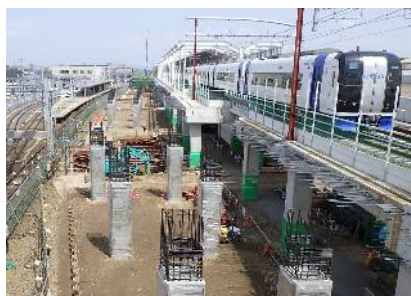
布袋駅付近高架化工事
