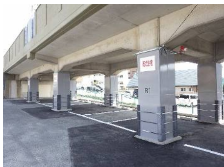
高架橋の耐震補強
