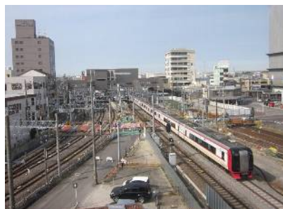
知立駅付近高架化工事
