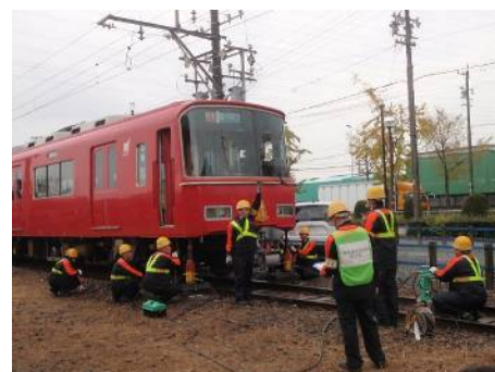
脱線復旧作業
