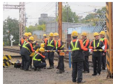
遮断桿更換作業
