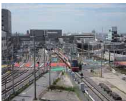
知立駅付近高架化工事
