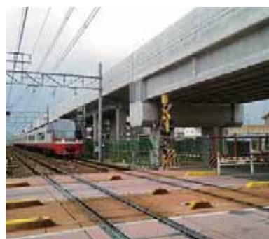
布袋駅付近高架化工事
