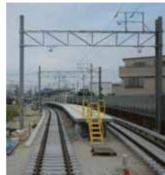
喜多山駅付近高架化工事
