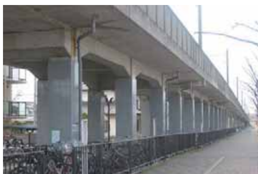
高架橋耐震補強
