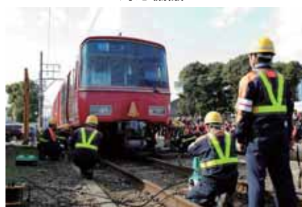
脱線復旧作業
