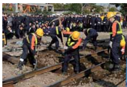
まくらぎ更换作業
