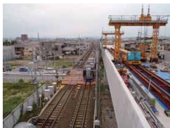
布袋駅付近高架化工事
