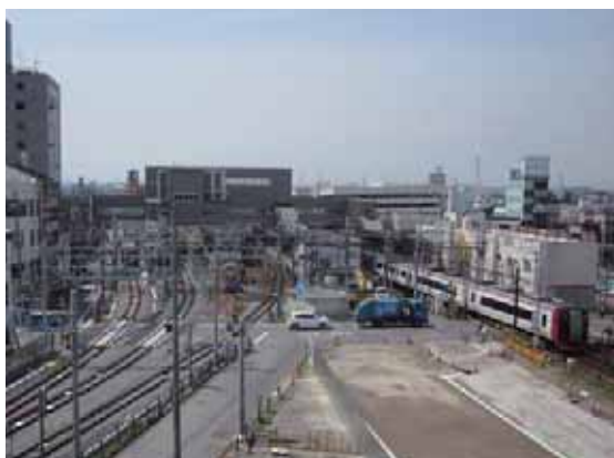
知立駅付近高架化工事
