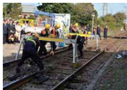
レール更換作業
