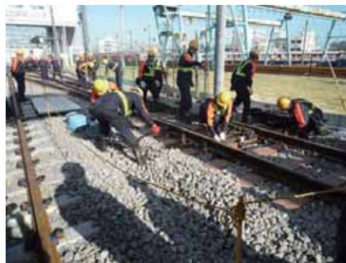
土木・電気合同復旧訓練
