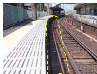
転落検知装置
