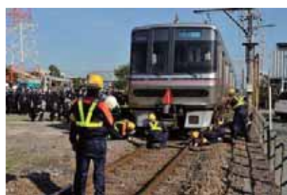
脱線復旧作業
