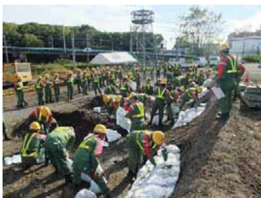
土木事故復旧訓練
