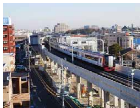
青山駅付近高架化工事
