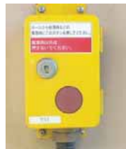
非常通報ボタン
