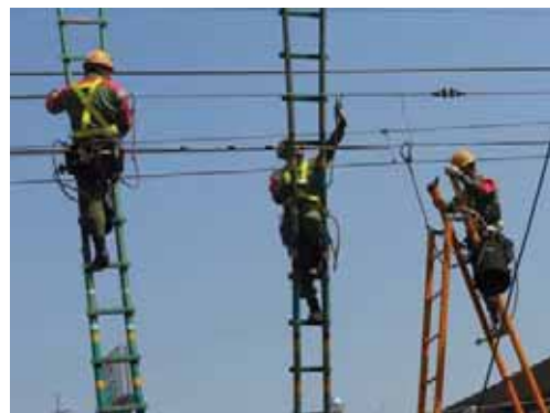
電気事故復旧訓練
