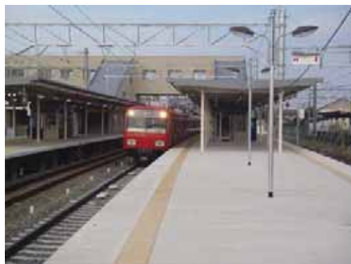
布袋駅付近高架化工事（仮ホーム）
