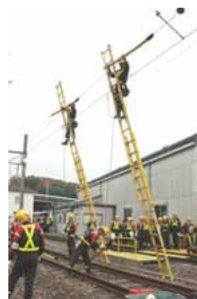
復旧作業（電気）
