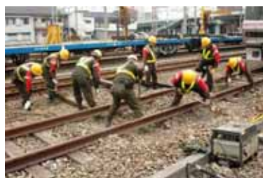
復旧作業（土木）
