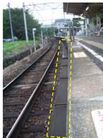
三河線・平戸橋駅 転落検知装置
