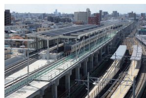
喜多山駅付近高架化
