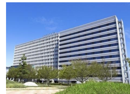
写真右側がPacific Side(新棟)
