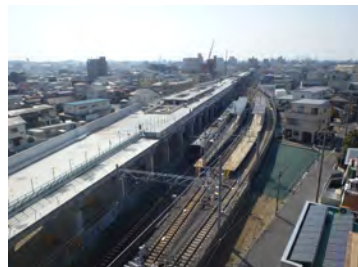
喜多山駅付近高架化工事
