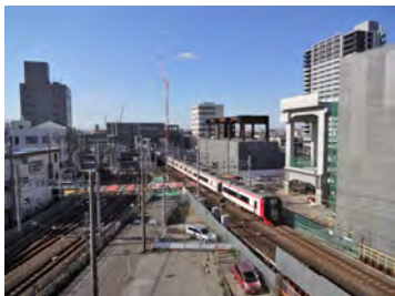
知立駅付近高架化工事
