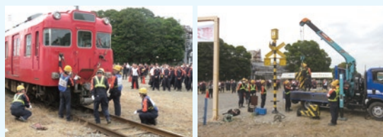
事故車両の復旧作業
