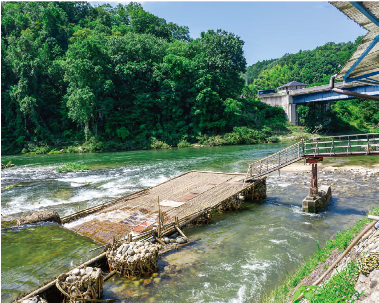
「広瀬やな」全体の大きさは、長さ約13m、幅約8m。上流にあたる手前側から流れてきた魚が「簀」にかかる仕組み。右手の橋は川岸に設けた客席とつながっている。
