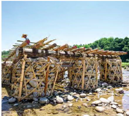
「蛇籠(じゃかご)」と呼ばれる竹籠に丸く大きな石を詰めて「やな」の土台に。「蛇籠」は堰にも使用される。
