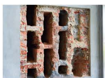
ビール造りには温度管理が重要。外気の影響を最小限に抑えるため、壁は5重構造に。
