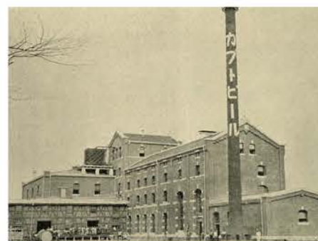
明治33年頃の「カブトビール」醸造工場(出典:日本之名勝)。総レンガの主棟に、木骨レンガ造りの平屋が接続している。
