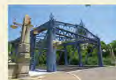
隅田川新大橋
