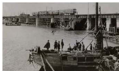
建設中の豊川橋梁
