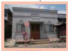
旧佐織勝幡郵便局 美しく塗り替えられていますが、造られたのは大正時代。壁面の装飾に大正期特有のモダンな建築デザインが見て取れます。
