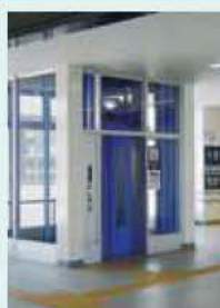
車いす対応エレベーター
