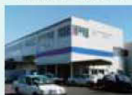
太田川駅仮駅舎
