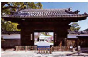
堂々とそびえる黒門。敷地内には、日本庭園「徳川園」もあります。
