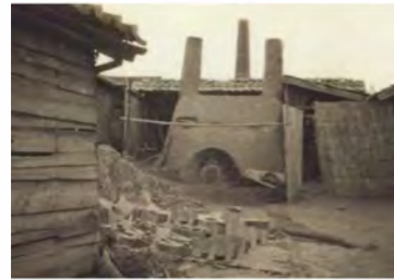
昭和初期、高浜の瓦屋の風景。当時は、窯の両側に焚き口がある「だるま窯」が主流だった。
