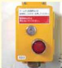
列車非常通報ボタン
