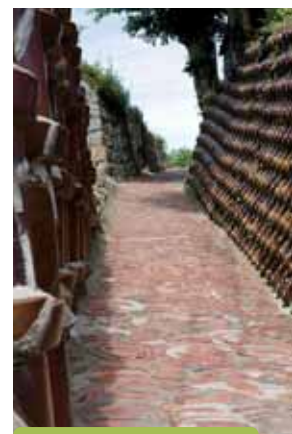
土管坂 左右の壁に朱色の土管や焼酎瓶が積み重ねられた細い坂道です。近くの休憩所からは港を見ることができます。
