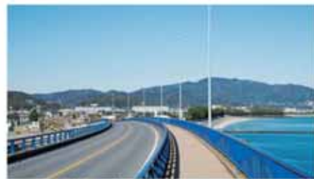
形原漁港大橋(ブルーブリッジ)
