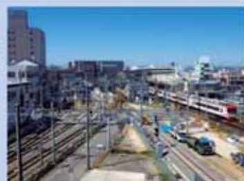
知立駅付近高架化工事
