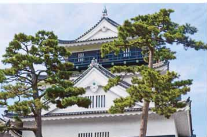
昭和34年に再建された天守閣。5階展望室からの眺望は見事。
