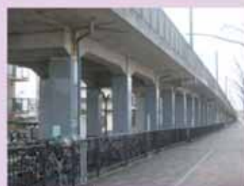
高架橋の耐震補強
