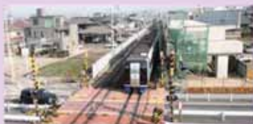
布袋駅付近高架化工事
