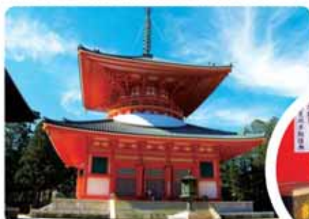
高さ48.5mもある「根本大塔」。
