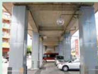
高架橋の耐震補強
