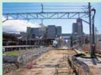
知立駅付近高架化工事
