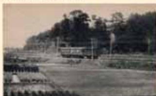
葵園駅付近(昭和2年頃)
