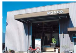
工場の中に入ると、右側奥に階段があります
