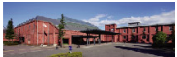
大正時代の赤レンガの工場建屋を生かした建物
