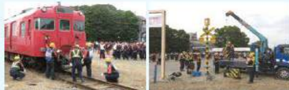
事故車両の復旧作業
