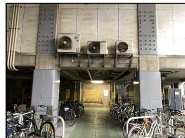
耐震補強工事後の高架橋
