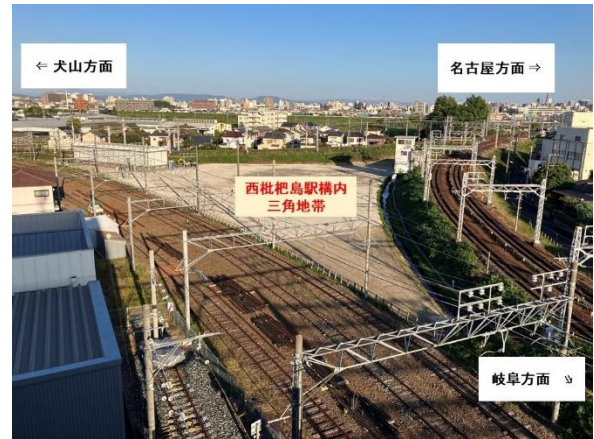
西枇杷島駅構内三角地帯 北側からの撮影
