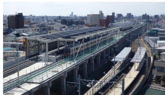
喜多山駅付近の高架化工事
