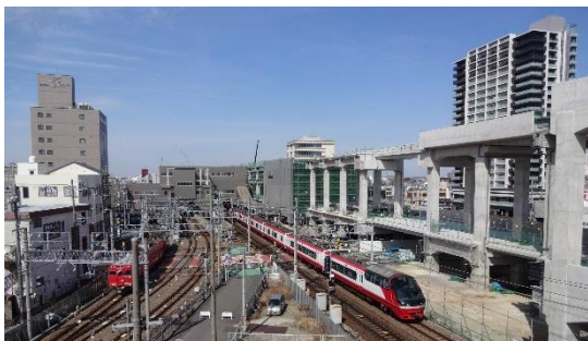
知立駅付近の高架化工事
