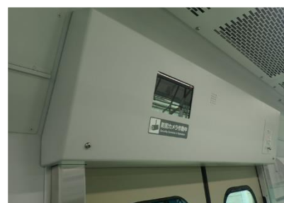
車内防犯カメラ(1両につき3か所設置)
