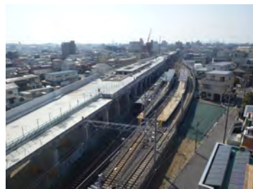
喜多山駅付近高架化工事
