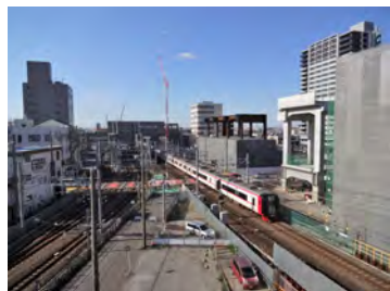
知立駅付近高架化工事
