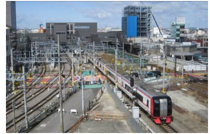
知立駅付近高架化工事
