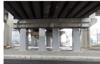
高架橋における耐震補強
