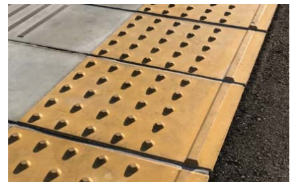
内方線付き点状ブロック
