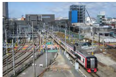
知立駅付近高架化工事
