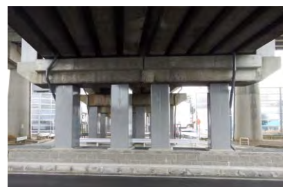
高架橋における耐震補強
