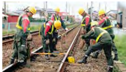
土木保守作業
