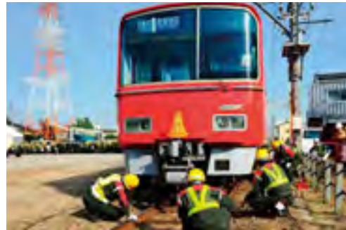
列車脱線事故復旧訓練
