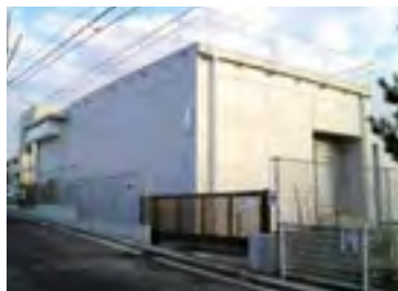
屋内型機器を採用した各務原変電所
