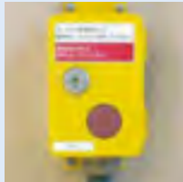
列車非常通報ボタン
