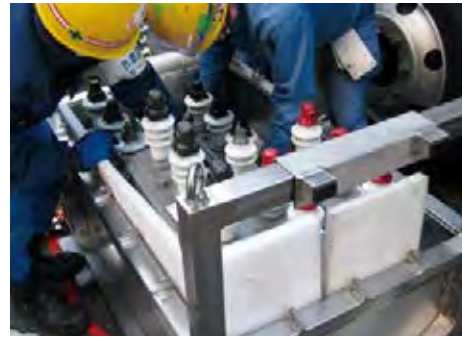
PCB廃棄物の搬出作業
