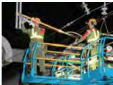
電気保守作業
