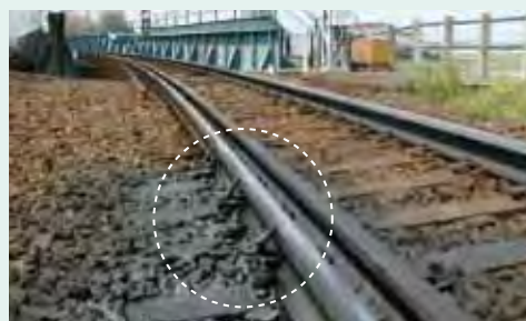
装置設置状況
