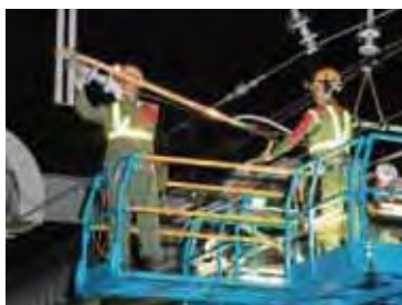
電気保守作業
