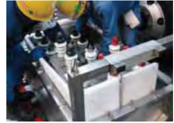
PCB廃棄物の搬出作業
