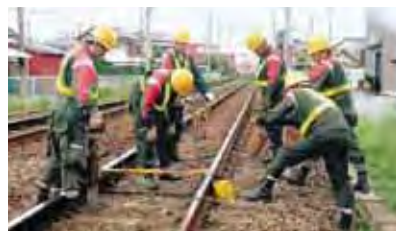
土木保守作業
