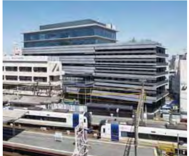
鉄道センタービル
