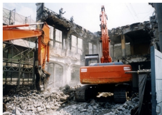
尾張瀬戸駅の解体
