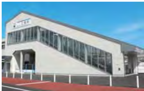
バリアフリー化した駅(土橋駅)
