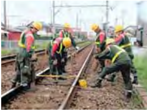
土木保守作業
