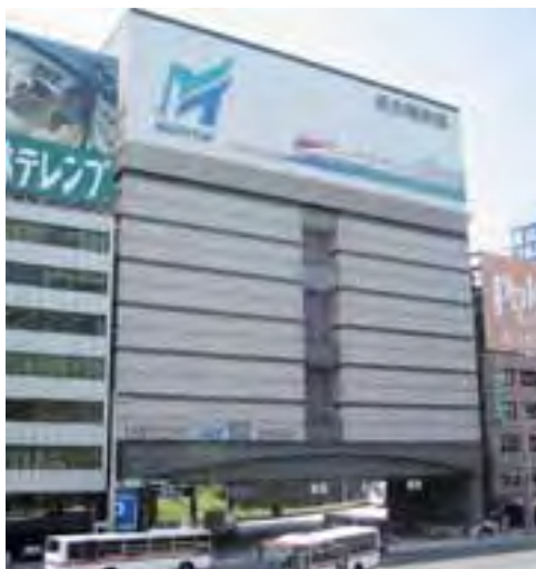
名駅南地域冷暖房プラントビル
