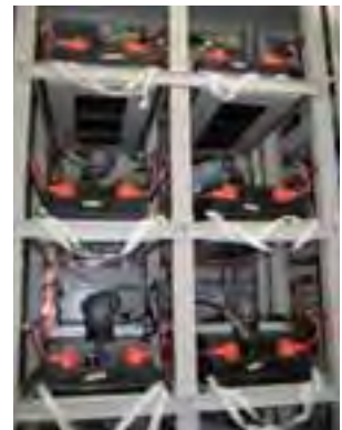
回生電力吸収装置
