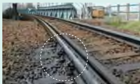
装置設置状況
