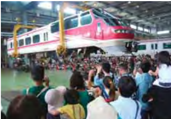
36tクレーンによる作業実演
