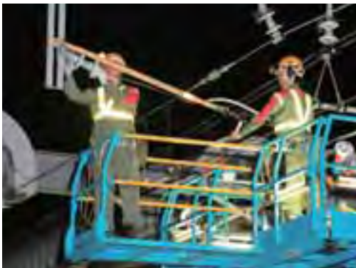
電気保守作業
