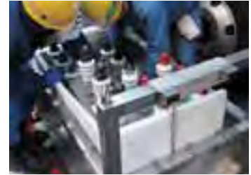
PCB廃棄物の搬出作業
