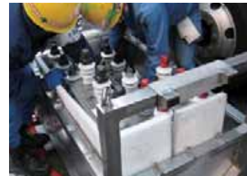
PCB廃棄物の搬出作業
