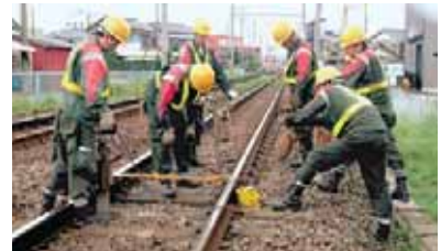
土木保守作業
