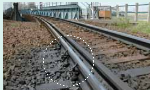
装置設置状況
