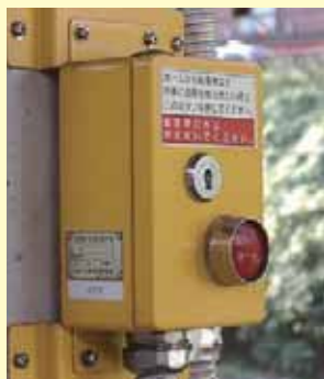
列車非常通報ボタン
