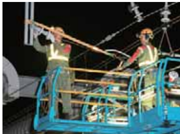
電気保守作業
