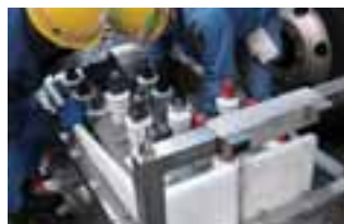
PCB廃棄物の搬出作業
