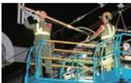
電気保守作業
