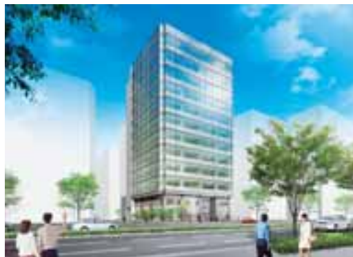
（仮称）名鉄不動産名駅ビル
