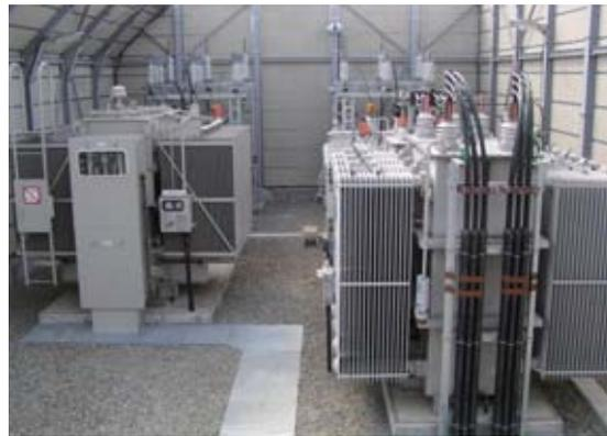
防音壁を設置した犬山変電所
