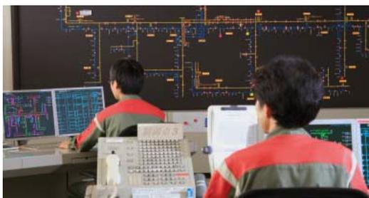
名鉄では、地震や台風、大雨などの自然災害に対して迅速に対応し、お客さまの安全を確保するとともに、障害発生時には早期に復旧し、運輸事業の公共的使命を果たすため、防災体制や情報システムの整備を進めています。全線の防災気象情報をリアルタイムで把握できる防災情報集中監視システムのほか、災害時に従業員の安否を確認し、復旧に必要な要員を早期に整える安否確認システムを平成18年8月に導入しています。
