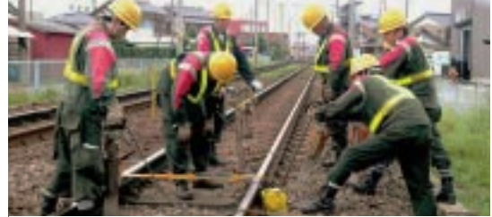
路盤整備作業
