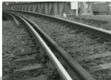
装置設置状況
