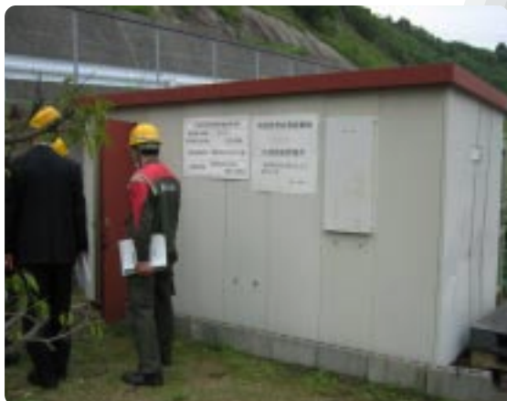
PCB保管庫(名鉄舞木検査場)
