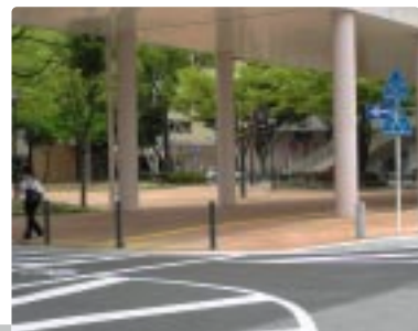
クールペーブ施工例(名鉄豊田市駅前広場)
