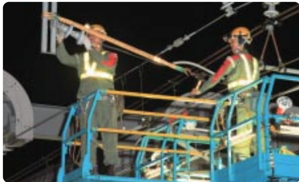
電車線の保守(名古屋鉄道)
