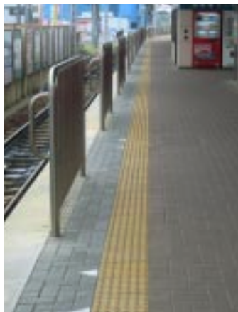
廃残土を含んだブロックで仕上げたホーム
