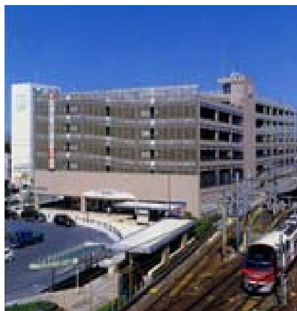
国府宮駅駐車場
