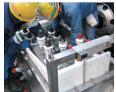
PCB廃棄物の搬出作業
