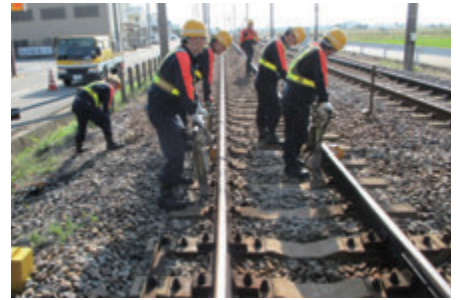
土木保守作業
