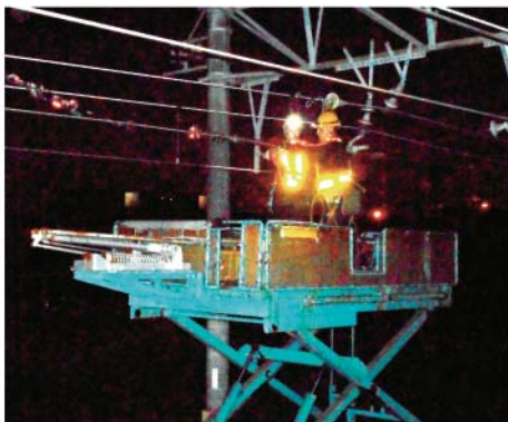
電気保守作業
