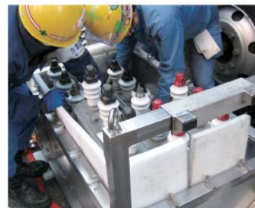
PCB廃棄物の搬出作業
