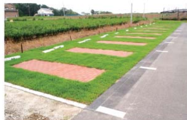
インターロッキングブロック(ILB)ハイブリッド施工事例 275m 2 22台駐車
