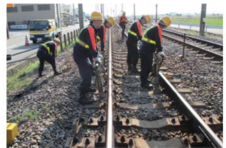
土木保守作業
