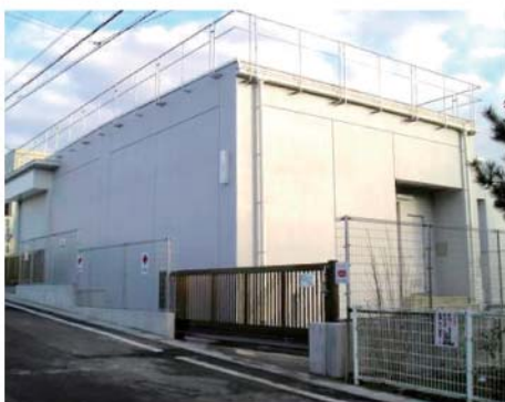
屋内型機器を採用した各務原変電所
