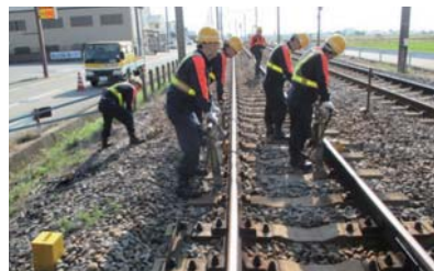
土木保守作業
