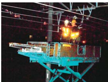
電気保守作業
