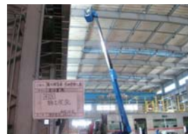
舞木検査場 LED照明化作業状況
