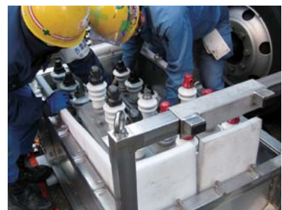
PCB廃棄物の搬出作業
