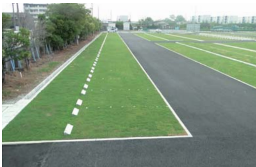
既存舗装直接施工 EGP 4,119m 2
